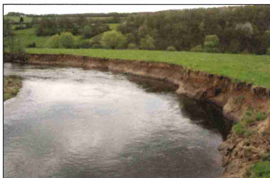
Berge naturelle le long du Viroin
