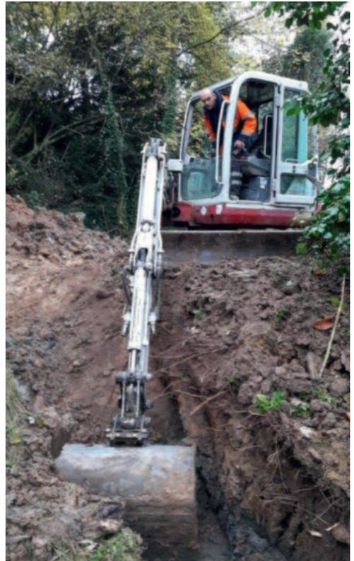
Creusement d’une tranchée pour retrouver la canalisation bouchée.
